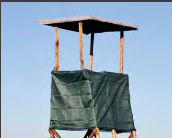
Dachkonstruktion 140 x 140 cm mit vier Pfosten und Tarnnetz - hat den Vorteil des Anstreichens bei stehendem Wild auf große Entfernung
